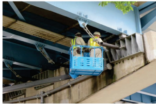
目視点検 出典：千葉市
