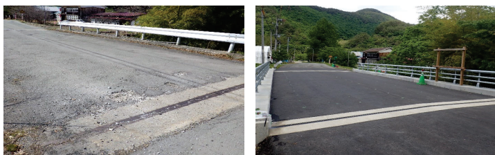
対象橋梁路面状況(左:床版取替前, 右:床版取替後)
