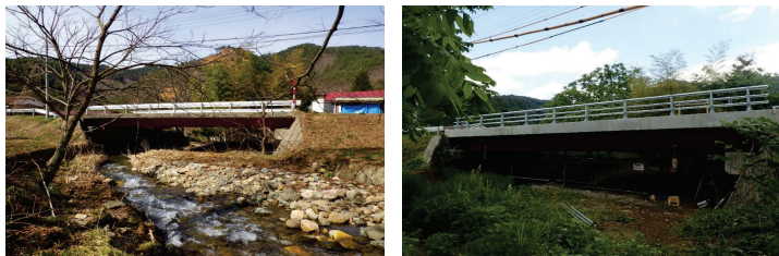
対象橋梁全景(左:床版取替前, 右:床版取替後)
