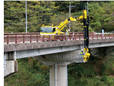
橋梁定期点検
