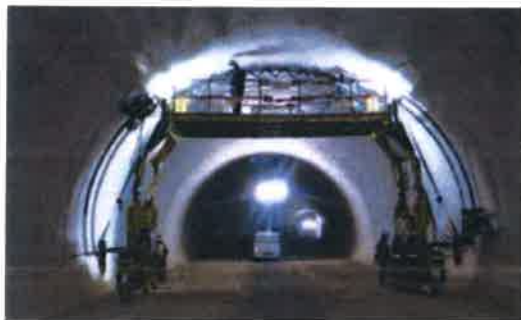
トンネル全断面点検システム
