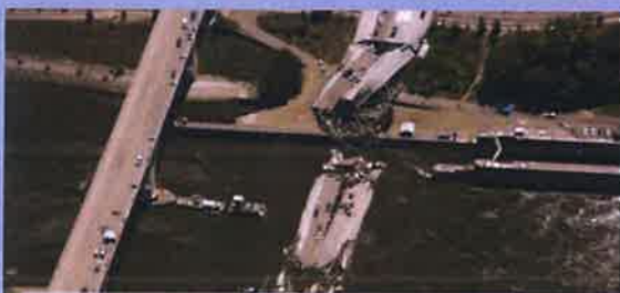
米国ミネソタ州ミネアポリス ミシシッピ川に架かる高速道路橋の崩落
