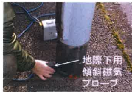
照明柱の高感度磁気 非破壊検査の状況
